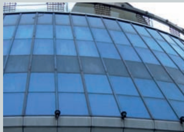
Основной причиной загрязнения фасадов является использование герметиков, содержащих органические масла
