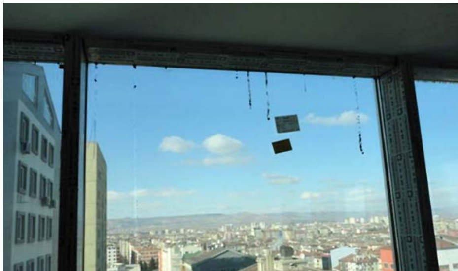
Рис. 3. Пример несовместимости материалов. Компоненты шовного герметика разрушили бутиловый герметик
